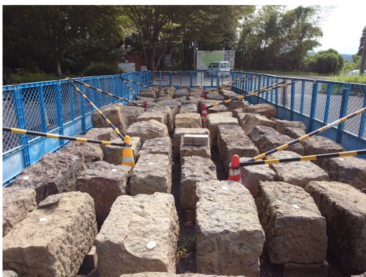
写真3 崩落した石材(仮置状況)
