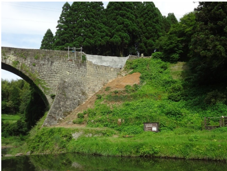
写真2 金網・モルタル被覆後 (応急処置後)
