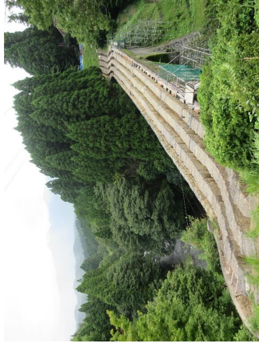
写真1 被覆土の掘削後（通水石管 露出）
