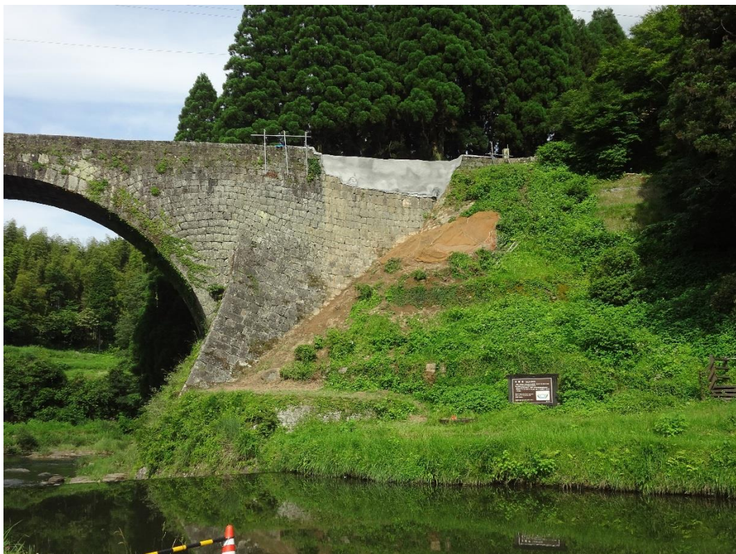
写真6 崩落防止処置（応急処置として、下から、ブルーシート、不織布、金網、モルタルを設置し崩落部位を被覆）※復旧工事の開始まで、雨水等の流入を防ぐため。
