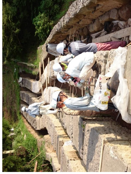
写真3 目地漆喰の詰め替え（充填）
