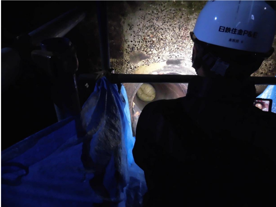
写真5 管更生材の出口側到達の状況（岩尾城側）
