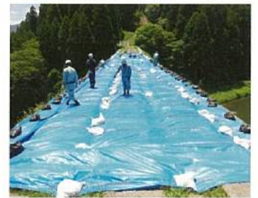
写真④ 現在の橋上の様子
