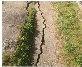
写真③ 橋上の被覆土に生じた地震による亀裂
