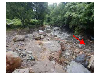
㊸ 溢水及び側方侵食・河床低下による護岸崩壊
