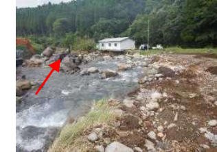
㊸ 溢水及び側方侵食・河床低下による護岸崩壊
