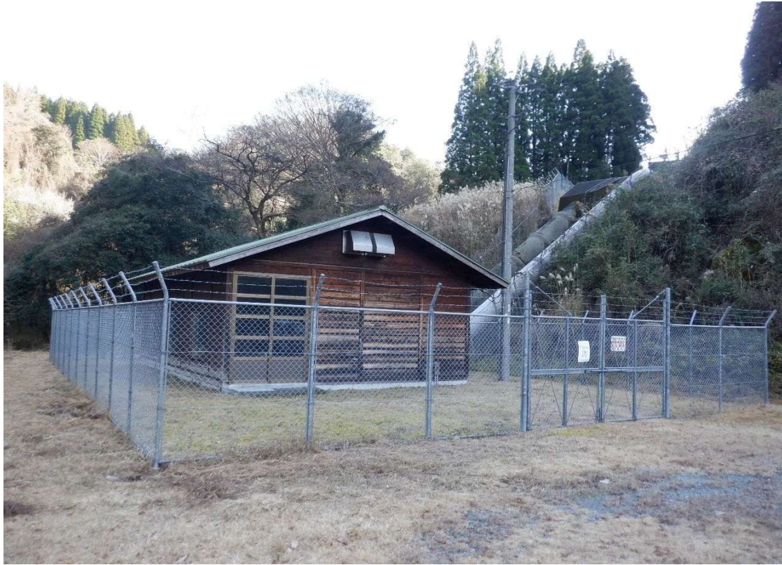
③建屋及び水圧鉄管、余水路
