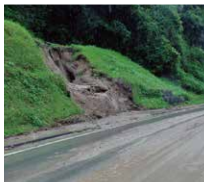
国道 218 号（白小野地区）
