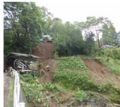
町道荒谷線（荒谷地区）
