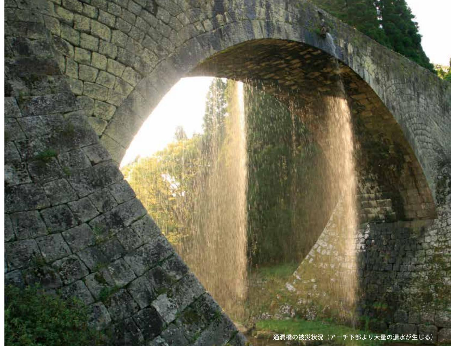
通潤橋の被災状況（アーチ下部より大量の漏水が生じる）
