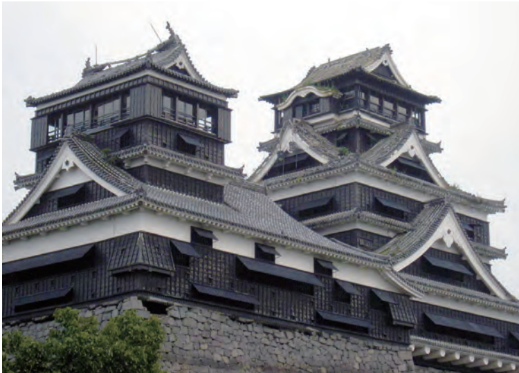
瓦が落ち石垣も崩れた熊本城天守閣
