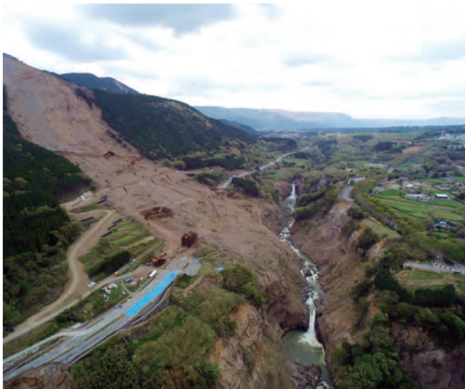
崩落した阿蘇大橋 (南阿蘇村)
